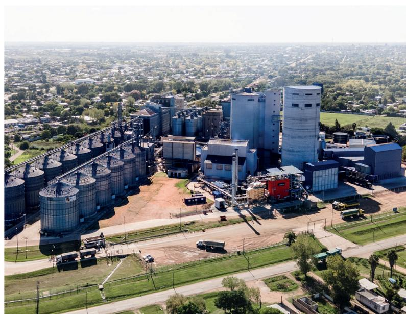
puede destacar la recuperación de energía calórica mediante el uso de intercambiadores de tubos de vidrio en secadoras de malta, el uso de precipitador electrostático para eliminar partículas de los gases de chimenea provenientes de la combustión en calderas, la planta de tratamiento de efluentes y recuperación del agua, y el reemplazo del uso de combustibles fósiles por Biomasa. Siendo también una empresa con Certificación ISO 9001-HACCP.-
